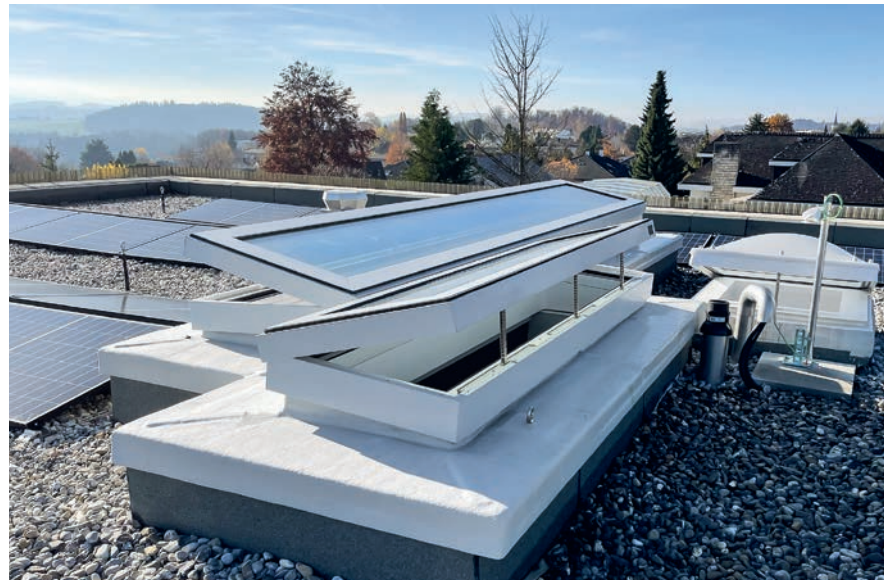
Der elegante Öffnungsmechanismus versteckt einen unsichtbaren 230-V-Kettenmotor.
