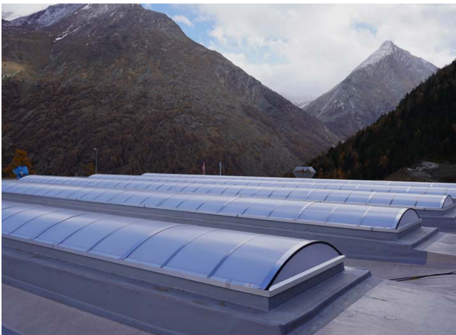
Als Lieferantin der sechs neuen Lichtbänder sorgte die Real AG für eine kombinierte Lösung aus hoher Tragfähigkeit und effizientem Tageslichteinfall.
